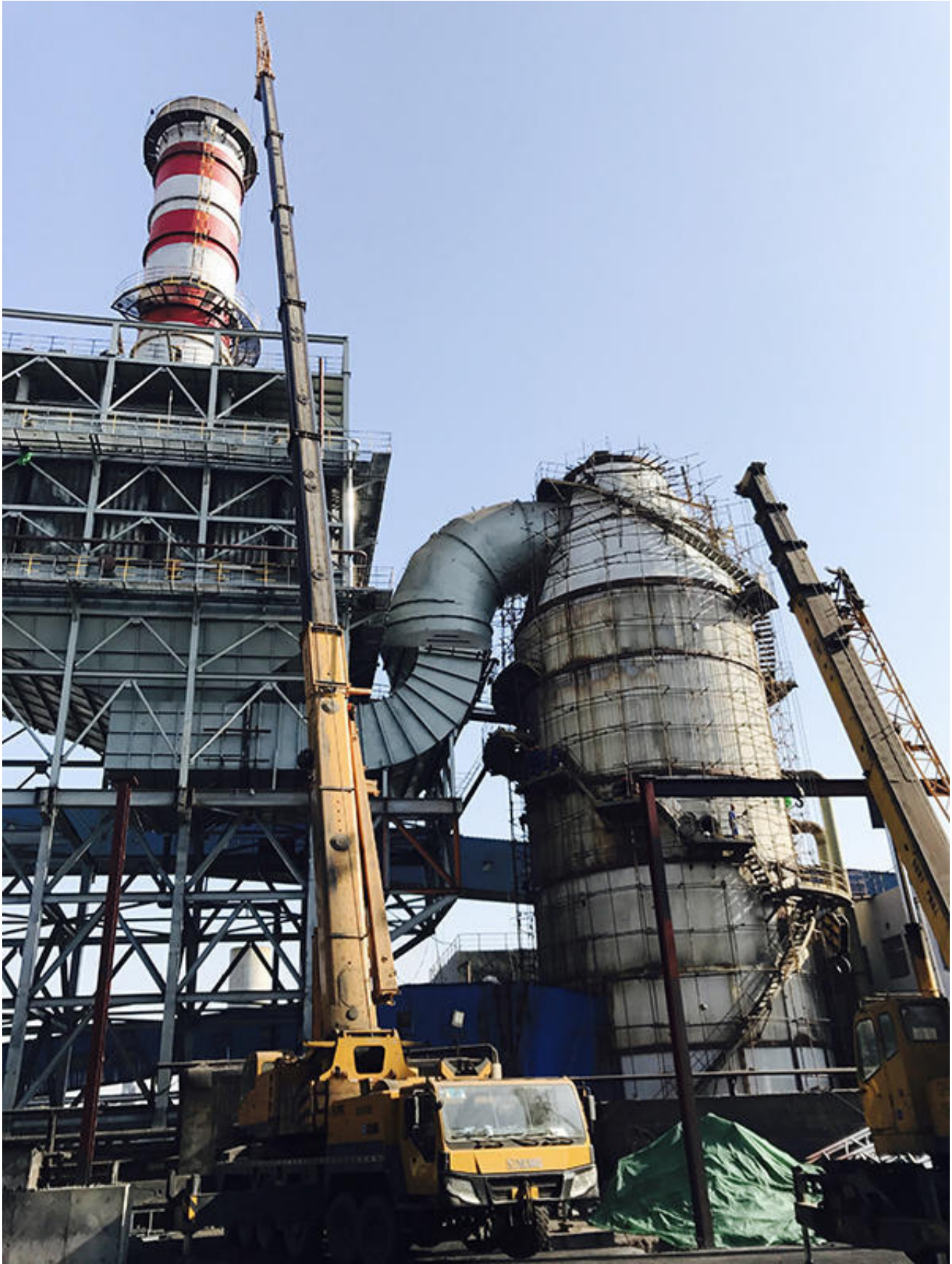
11月18日，新兴铸管公司正在高炉焦炭上料口处安装集尘罩。
